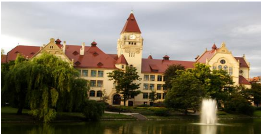
Rys.5 Pierwsza siedziba Wydziału Elektroniki (dawniej Wydziału Łączności) i Instytutu Cybernetyki Technicznej do 1970r. (widok aktualny – Budynek E-1 przy ul. B.Prusa 53/55).
